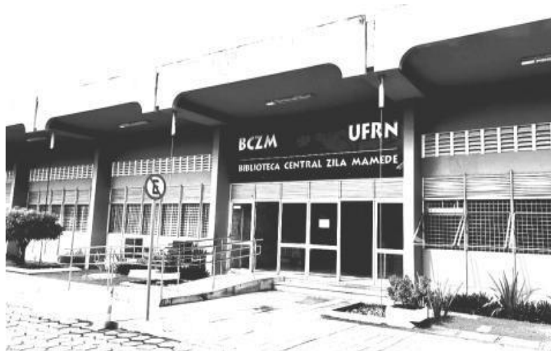
Fotografia 15 – Fachada da Biblioteca Central “Zila Mamede” – BCZM. Rua da Biblioteca, s/n – Campus Universitário – Lagoa Nova. Caixa Postal: 1524 CEP: 59078-970 – Natal-RN Fonte: Portal BCZM/UFRN. Galerias. Fotos
