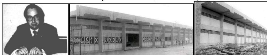
Figuras 16 a 18- O arquiteto Alcyr Meira responsável pelo Projeto Arquitetônico da BC. A Fachada principal da BC, em construção (1975) 16 . A Fachada posterior da BC, em construção.
