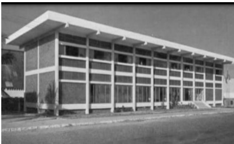
Fotografia 15 – Fachada da Biblioteca Pública Câmara Cascudo (1969) Rua Potengi, 353 – Petrópolis, Natal/RN Fonte: Google. Imagens
