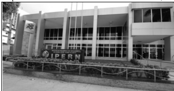
Figura 9- O prédio onde seria a Biblioteca Pública Estadual do RN, Rua Jundiáí 7 .
